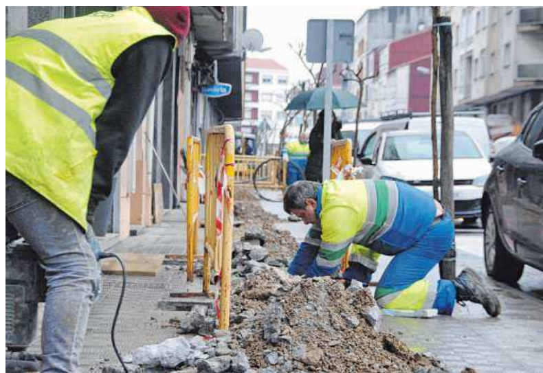
Trabajadores de la empresa Aqualia, en unas obras de mejora de la red en la calle San Pedro. c.c.
