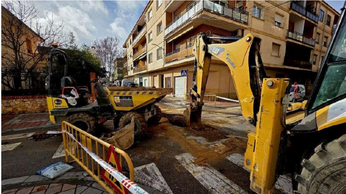
Aspecto que presenta la calle Tomás Prieto en plenas obras. - Foto: Ayuntamiento de La Roda
