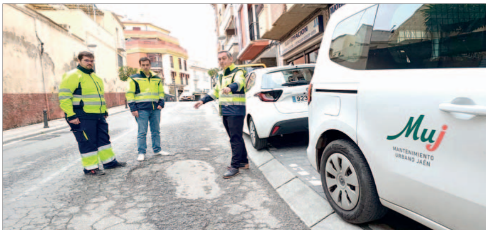
FIRME. El concejal Javier Padorno revisando calzadas con severos daños por baches.
