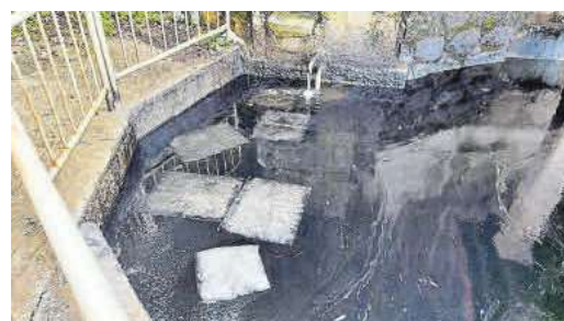
El lavadero de A Regueira sigue cubierto de hidrocarburos. | S.A.
